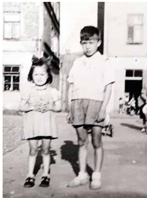
► Aleksander Olszewski z siostrą Joanną na placu po synagodze, ul. Podwalna, po prawo budynek nr 3.
